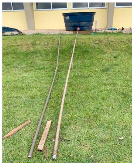
Figura 02 – Instalação da Caixa d'água de 1000 Litros
