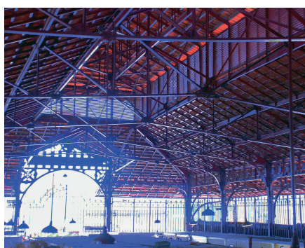
Figura 1. Estrutura Metálica do MPCA Google (2021).
